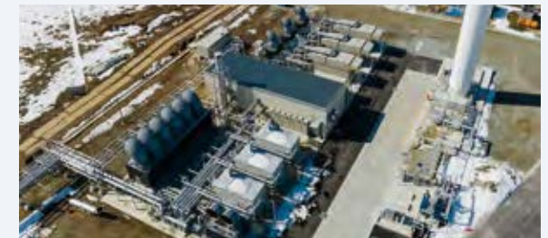
Yamagata Prefecture ESP service energy center for BIS
