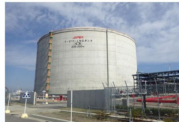
相馬LNG基地
