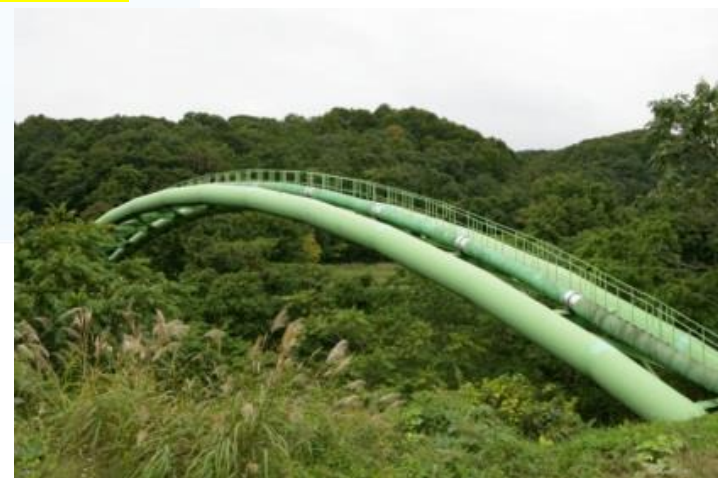
新潟・仙台間ガスパイプライン
