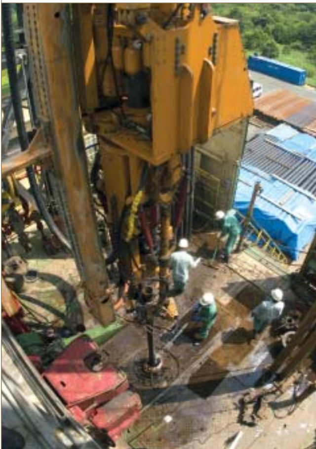
ドリルフロアーでの掘削作業
