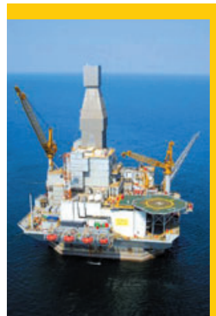
チャイウォ油ガス田で掘削作業中のオーランプラットフォーム (エクソン・ネフテガス社提供)
