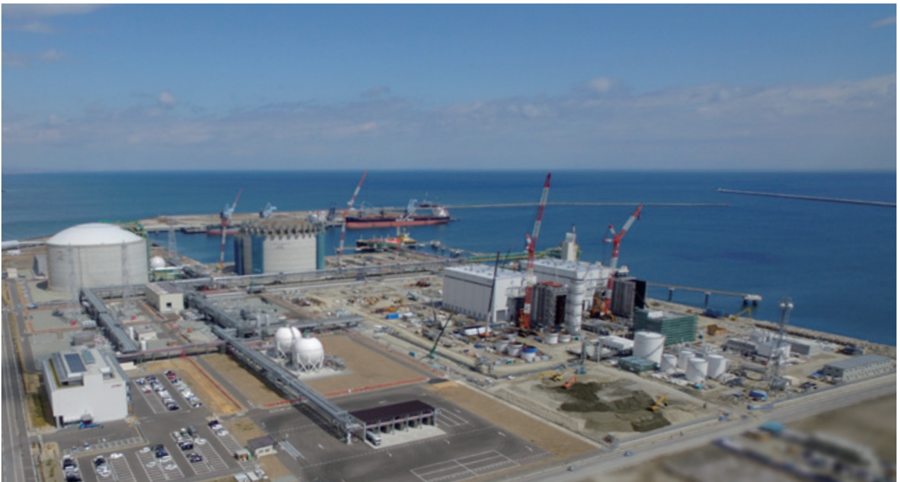
相馬LNG基地と建設中の福島天然ガス発電所
