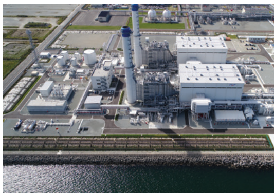
▼ 福島ガス発電(株)福島天然ガス発電所
