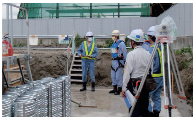
工事現場でのHSEオフィサー活動の様子
