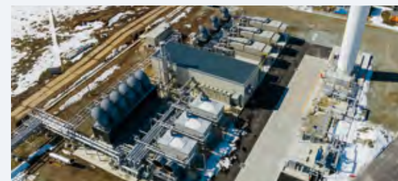
山形県 BIS向けESPサービスエネルギーセンター
