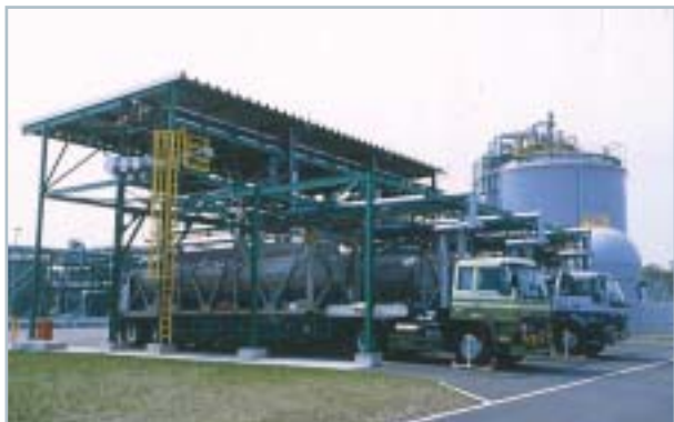
勇払LNGプラント(北海道苫小牧市)
