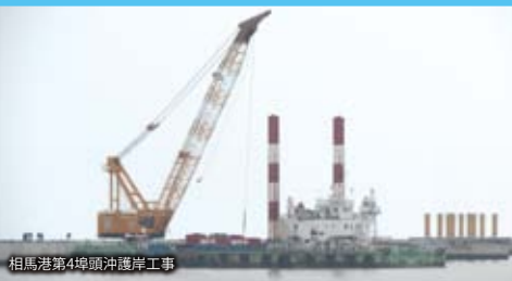
相馬港第4埠頭沖護岸工事
