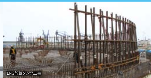
LNG貯蔵タンク工事
