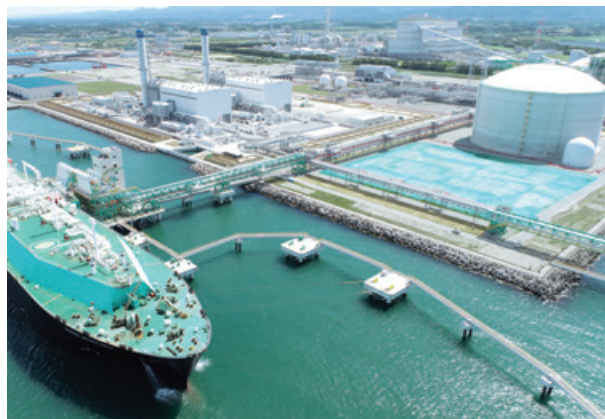
外航船棧橋側からみた発電所(左)と相馬LNG基地
