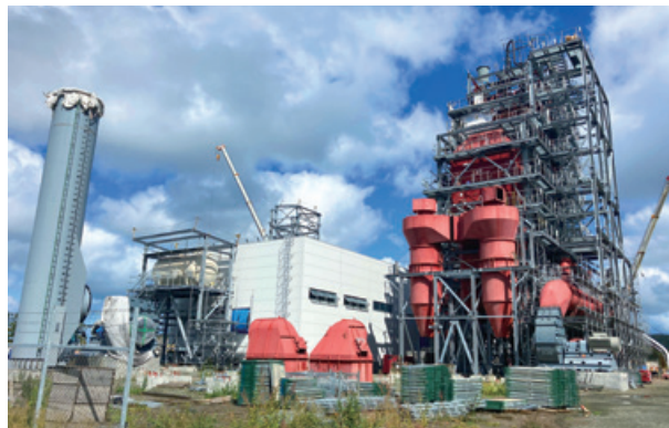
網走バイオマス発電所2号機建設地(2021年9月撮影)
