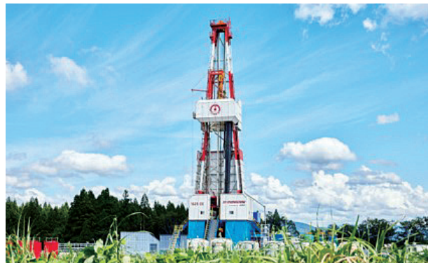
掘削装置（ドリリングリグ）全景
