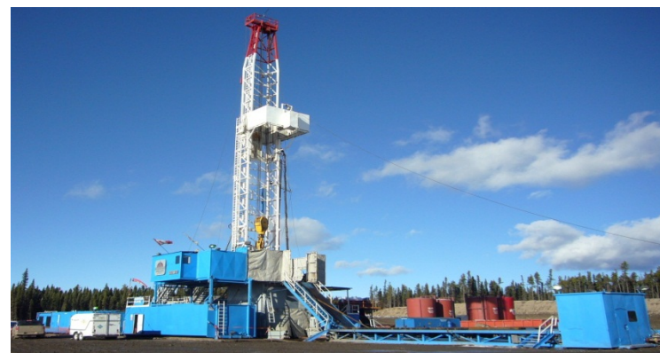
ノース・モントニー地域での掘削作業
