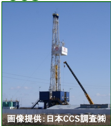
CCS観測井の掘削作業
