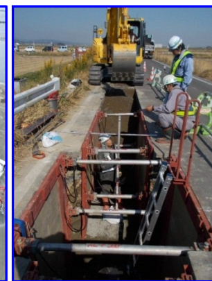
接続パイプライン 着工(10/7)
