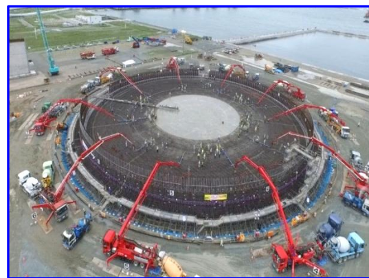
相馬LNG基地 コンクリート打設工事 (6/28~29)の様子 ・コンクリート打設量:9,778m 3 ・ミキサー車:延べ2,317台
