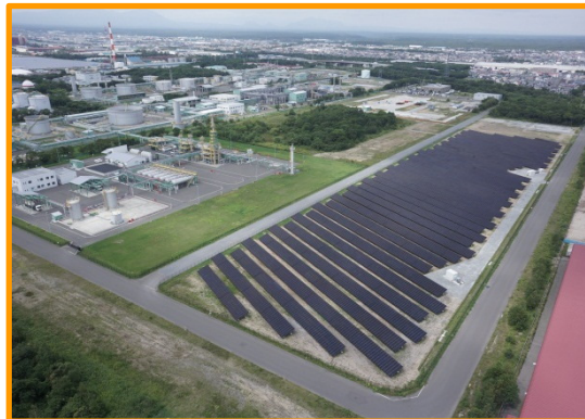
北海道鉱業所メガソーラー発電所
