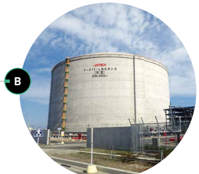
相馬LNG基地
