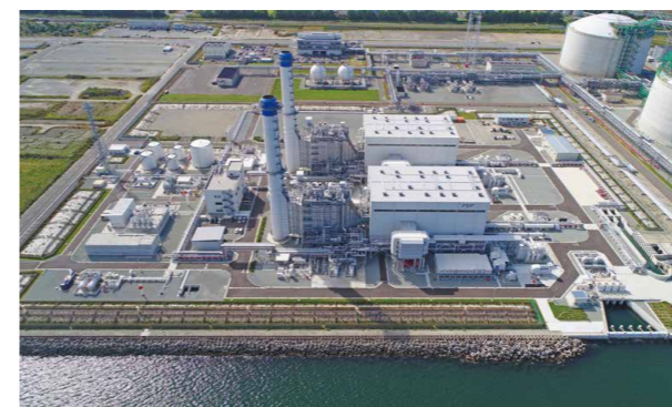
△ 福島天然ガス発電所（福島ガス発電（株））
