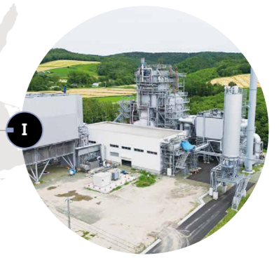
網走バイオマス発電所 2号機・3号機
