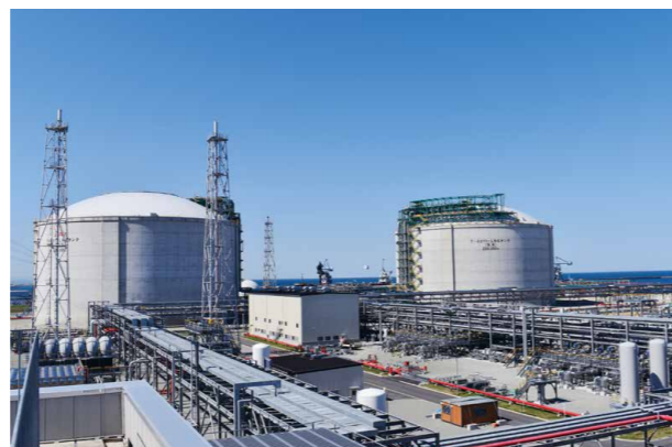
△ 相馬LNG基地
