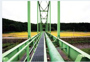
新潟・仙台間ガスパイプライン
